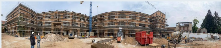
Immagine 3: i lavori in corso presso l'ex caserma Garibaldi
